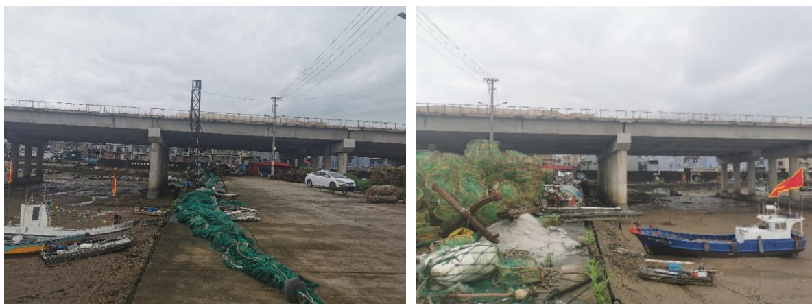
图 2.1-3 东岙大桥立体确权段现状
